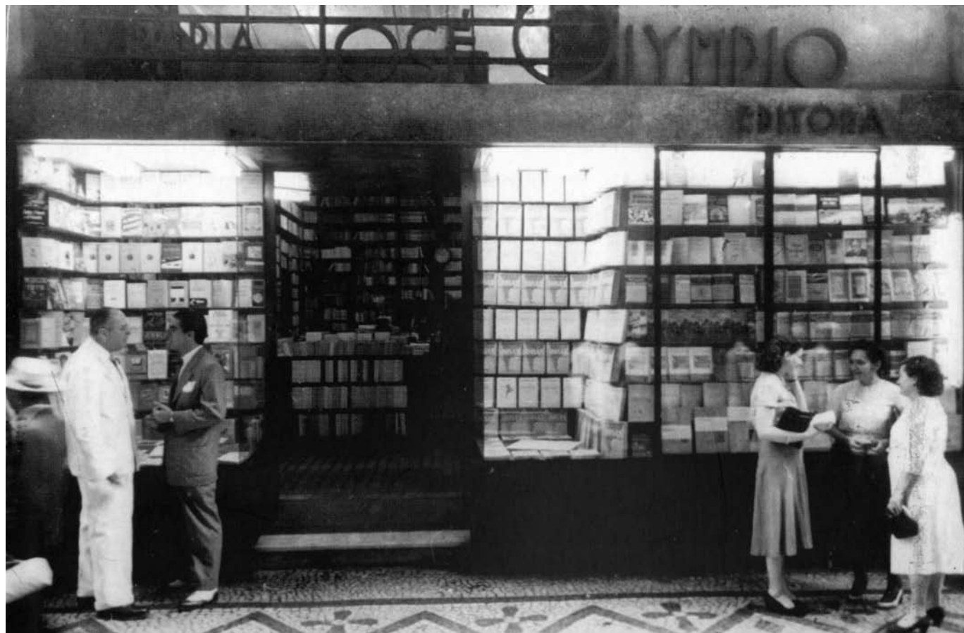
Fachada da antiga livraria José Olympio.
